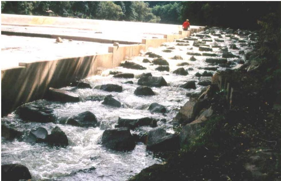
Figure 7 : Ecoulement au travers d'enrochements en rangées périodiques
