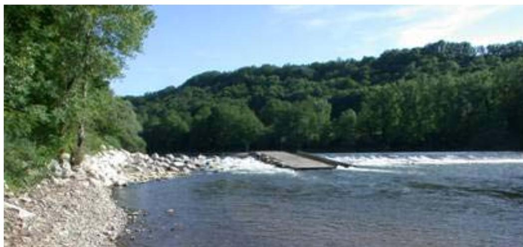
Figure 16 : Rampe en enrochements de Carennac (Dordogne)
