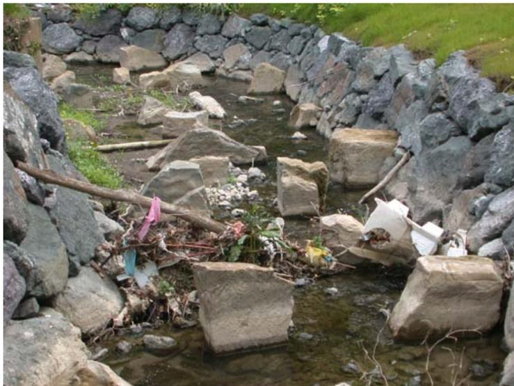
Figure 28 : Exemple d'embâcles au sein de dispositifs.
